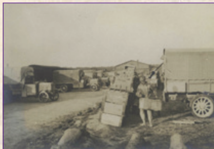
Chargement d'un convoi automobile de munitions, gare de Ligny, 22 mai 1915 - Val316_183
